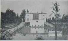
Kolding kontorbygning og vaskeri
