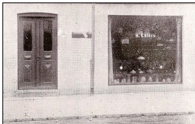
H. Ehlers Installationsforretning.
