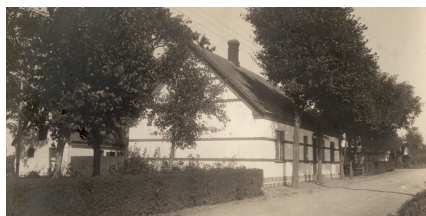
I 1904 byggede Laurids Rasmussen ny bolig til sin farbror smedemester Niels Jørgen Nielsen, Vedde. Huset er fotograferet i 1926.
