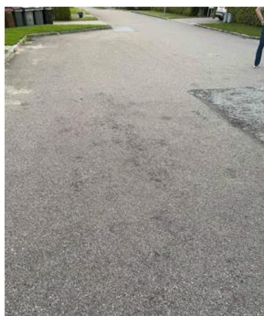
Overflade skader og lunger ved vendepladsen mod 223 og 225
